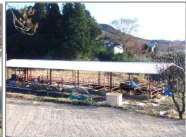
鉄筋牛舎（建設中）
