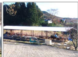
鉄筋牛舎(建設中)
