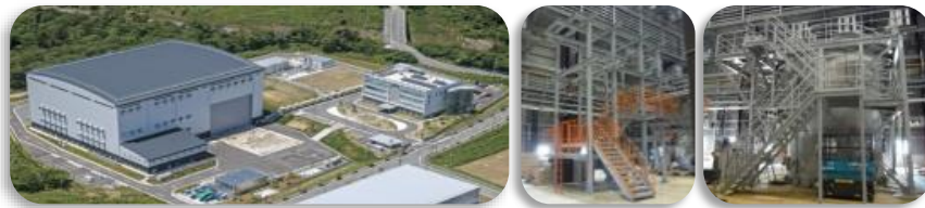
楢葉遠隔技術開発センター
