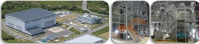
楢葉遠隔技術開発センター
