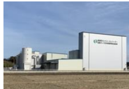
平成31年度本格稼働予定の カントリーエレベーター
