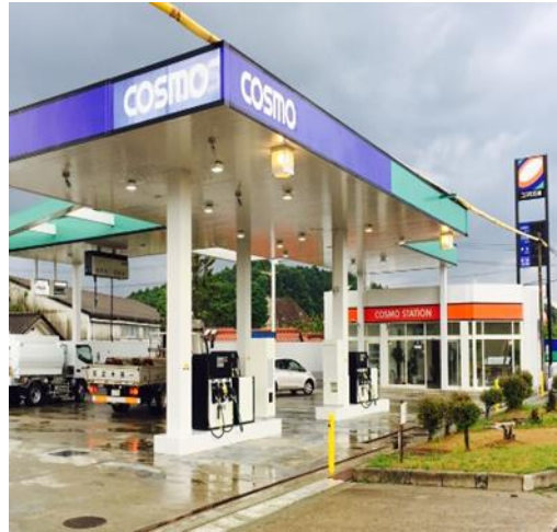
改修後のガソリンスタンド
