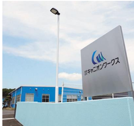
いわき工場外観
