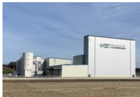
令和元年度本格稼働予定の カントリーエレベーター
