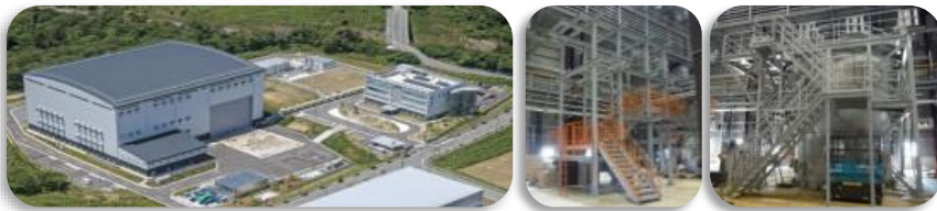
楢葉遠隔技術開発センター
