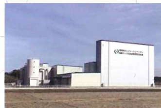
平成31年度本格稼働予定のカントリーエレベーター
