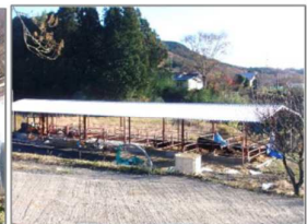
鉄筋牛舎（建設中）
