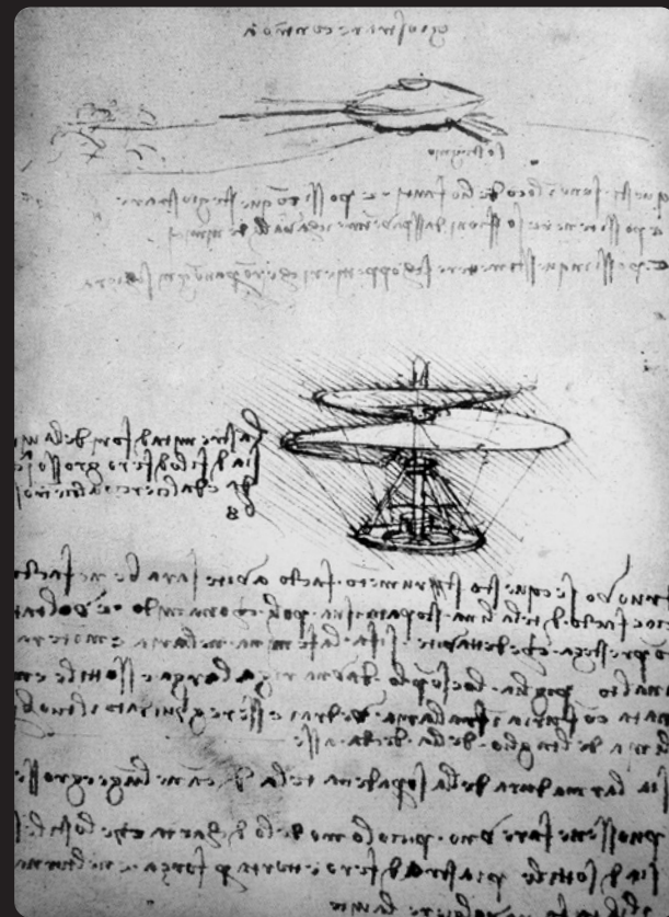
1480年代後半、レオナルド・ダ・ヴィンチがスケッチした 「空気スクリュー(aerial screw)」
