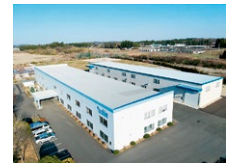
2018年12月鹿島第二工場竣工
