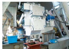
フラップダンパー据付
