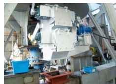
フラップダンパー据付
